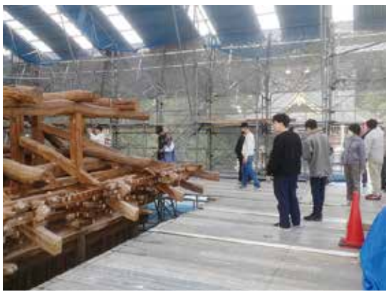
(重文) 本寺楼門解体修理見学
