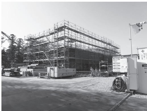
道路側からの工事現場
