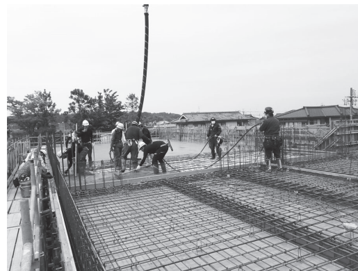
2階床部分のコンクリート打設状況
