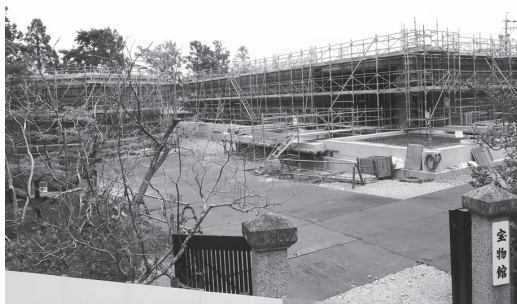
旧宝物館門扉側からの工事現場全景
