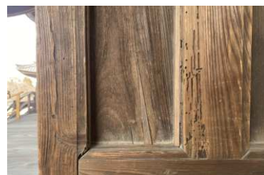
鏡板の割れ補修完了
